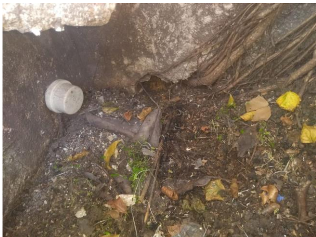
CAIXA DE ESGOTO INTERNAMENTE BLOQUEADA DE RAÍZES
